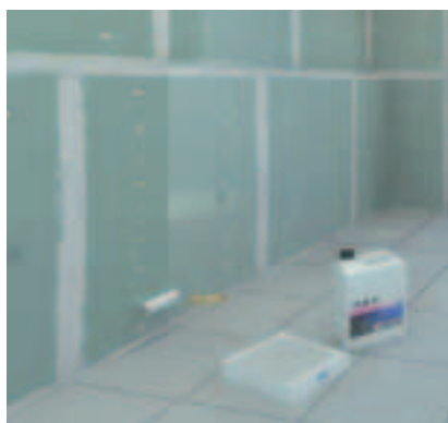
HELYES: FALFELÜLET ALAPOZÁS
